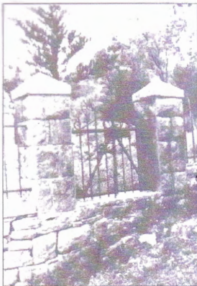
Изглед улазне капије -прије радова
